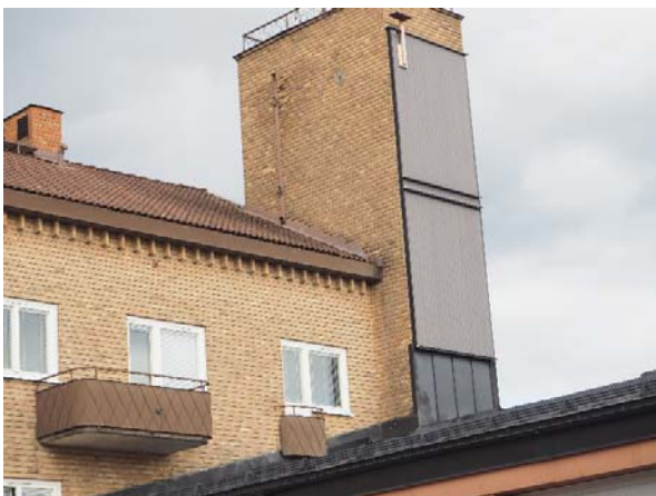
Detalj, balkonger, takfot och torn
