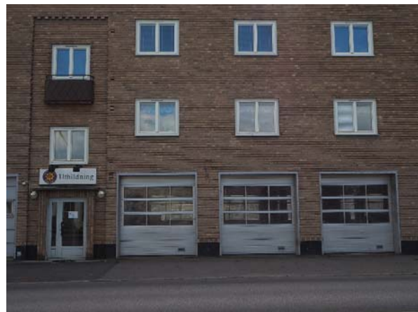
Fasad med entré och garageportar mot Djulögatan
