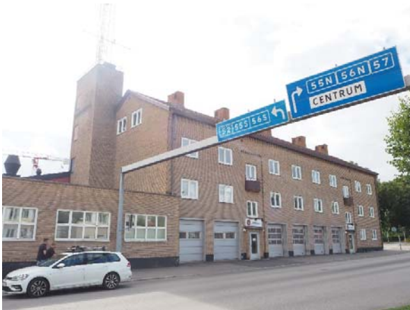
Brandstationen sedd från Djulögatan
